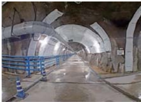
⑨ 500m研究アクセス南坑道 本坑道は、長さ118.65m、高さ3.5m、幅4m。坑道内では地下水観測の他に湧水抑制対策や物質移動試験などが実施されている。
