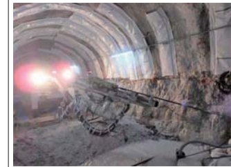
ポストグラウチングの施工風景
