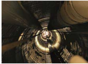
① 主立坑 掘削深度：500.4m、内径：6.5m 平成23年7月に深度500mに到達。主立坑側の研究坑道への資材及び作業員の運搬に使用。
