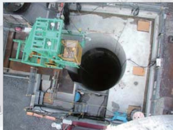
換気立坑の坑口
