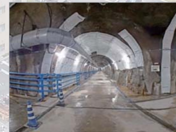
完成した深度500m研究アクセス南坑道
