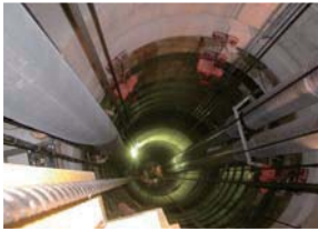
⑥ 換気立坑 掘削深度：500.2m、内径4.5m 平成23年4月に深度500mに到達。換気立坑側の研究坑道への資材及び作業員の運搬、主立坑のバックアップ施設の役割を担う。
