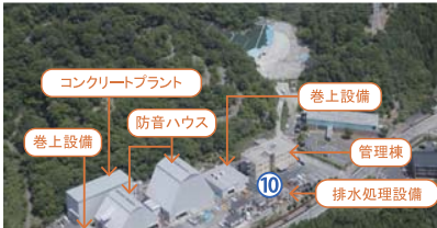
コンクリートプラント、巻上設備、防音ハウス、管理棟、排水処理設備、工事施工者事務所、受変電設備（非常用発電設備）
