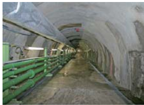
③ 300m研究アクセス坑道 本坑道は、長さ95.7m、高さ3m、幅4m。坑道内では地下水観測の他に地震観測や微生物などの研究が実施されている。
