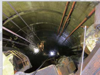
排水停止により水没した立坑
