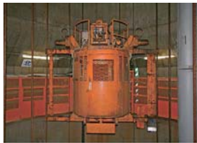
② 主立坑の工用エレベータ 主立坑の工用エレベータの定員は10名。深度500mまでは約5分で到着する。
