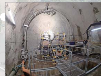
完成した深度500m研究アクセス北坑道の止水壁
