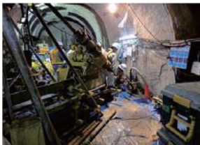
⑧ 300mボーリング横坑 本坑道は、長さ16.4m、高さ3m、幅4m。坑道内では地下水観測の他に物質移動試験などが実施されている。
