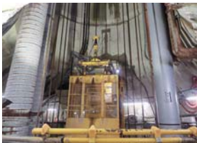
⑦ 換気立坑の工用エレベータ 換気立坑の工用エレベータの定員は5名。深度500mまでは約5分で到着する。
